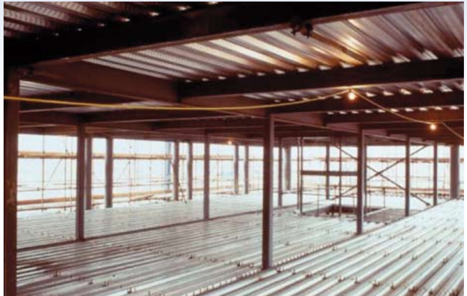
Afb. 2.1 Staalplaat-betonvloeren bieden een veilige werkvloer tijdens de bouw.
