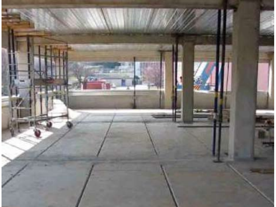
Afb. 4.3 Aanblik van de Cofradal vloer voordat de betonnen druklaag is gestort.
