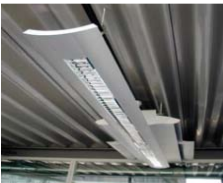
Staalplaat-betonvloer van roestvast staal is in het zicht gehouden. In het eronder hangende element zijn ventilatie en lichtvoorziening geïntegreerd.
