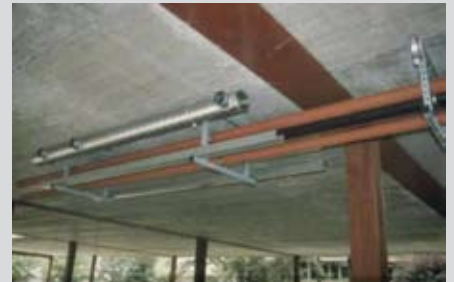
Afb. 2.3 Leidingflexibiliteit bij geïntegreerde liggers met kanaalplaten.
