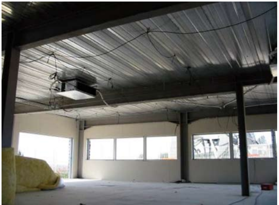
Afb. 4.4 Onderzijde van de voltooide Cofradal vloer. Voor leidingen en installaties is een verlaagd plafond nodig.
