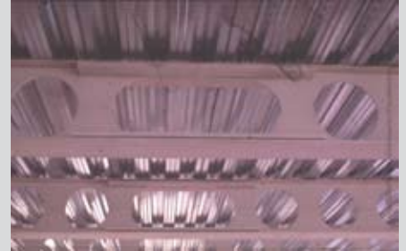
Afb. 2.2 Langgerekte openingen in stalen liggers met horizontale verstijvingen.
