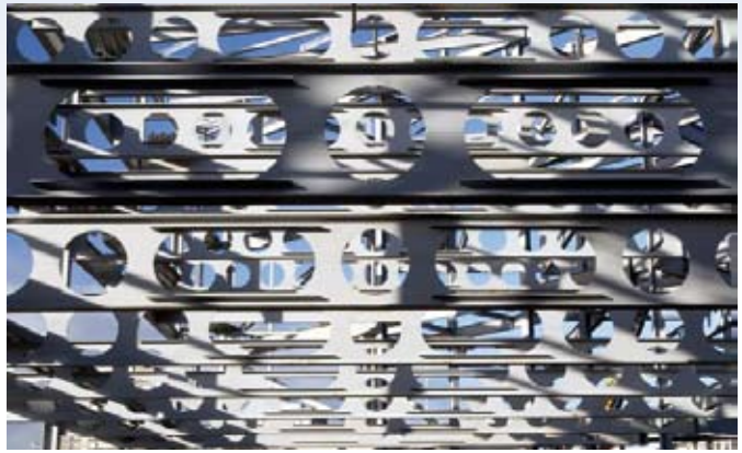
Afb. 2.6 Liggers met grote overspanningen bieden makkelijke leidingintegratie.
