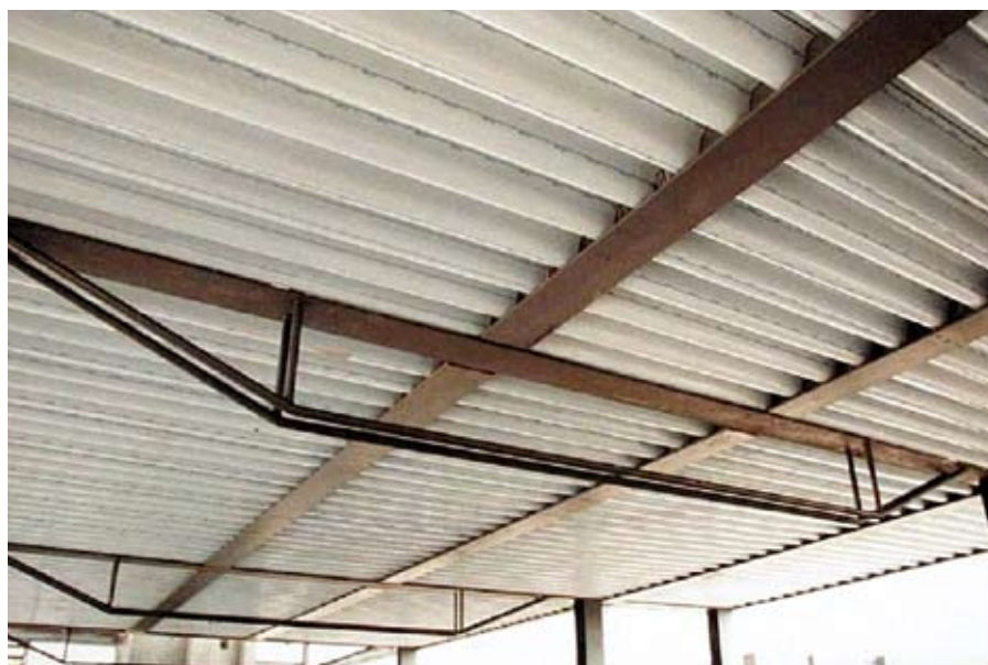
Afb. 3.7 Een extra lange onderspannen geïntegreerde ligger die is gebruikt in het gebouw van de Kamer van Koophandel in Luxemburg.
