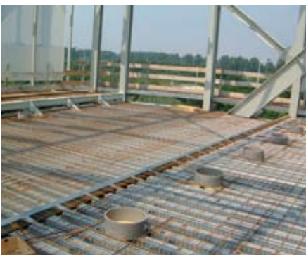
Staalplaat-betonvloer in de gehoorzaal.
