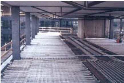
Waterleidingen voor koeling en verwarming geplaatst in het betondek.
