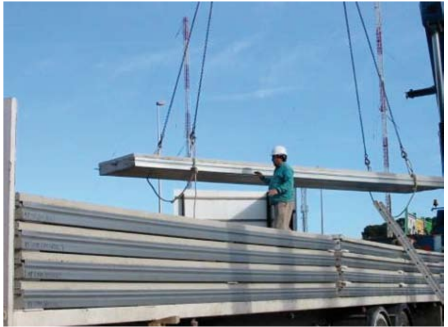
Afb. 4.2 Levering van Cofradal 200 op de bouwplaats.
